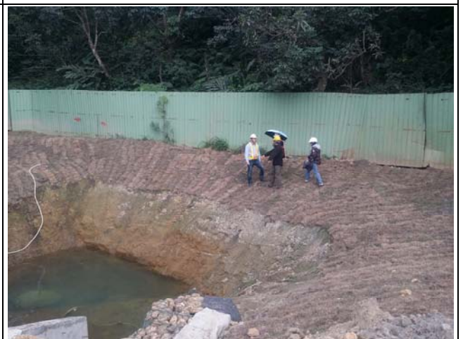
4. 生態池東南側動物通道 C 施工現況
