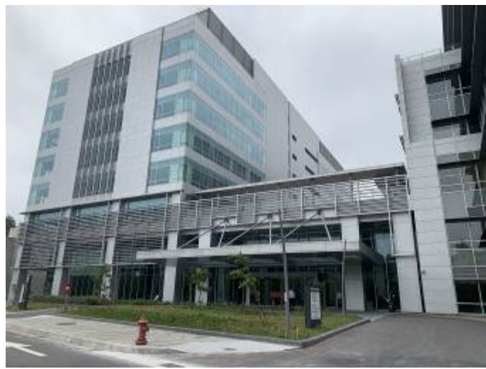
C棟立面現況
