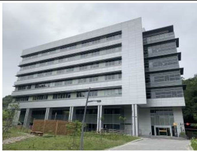
E棟立面現況
