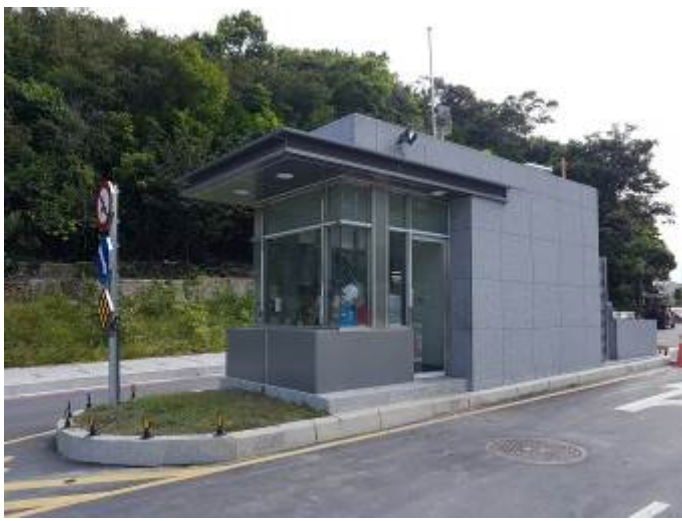
I 棟南側警衛亭現況
