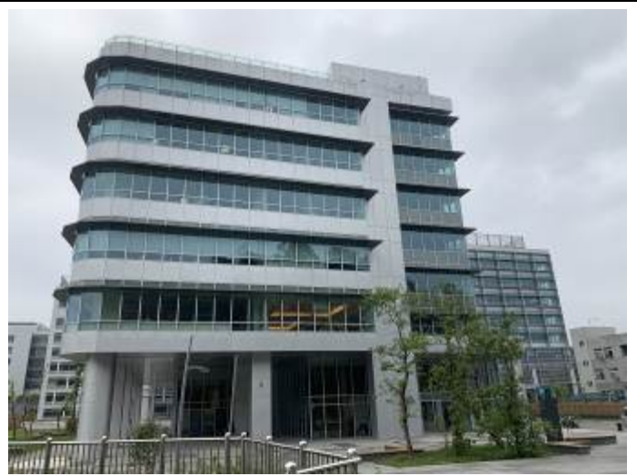
F棟立面現況
