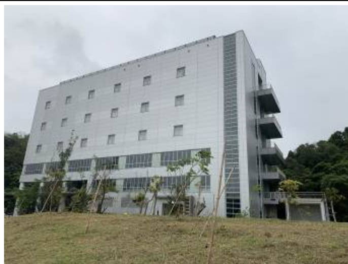
G棟立面現況
