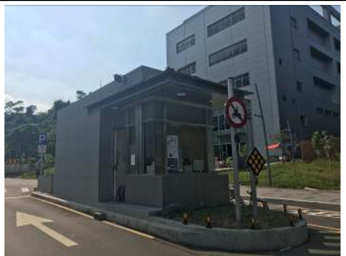
H棟北側警衛亭現況
